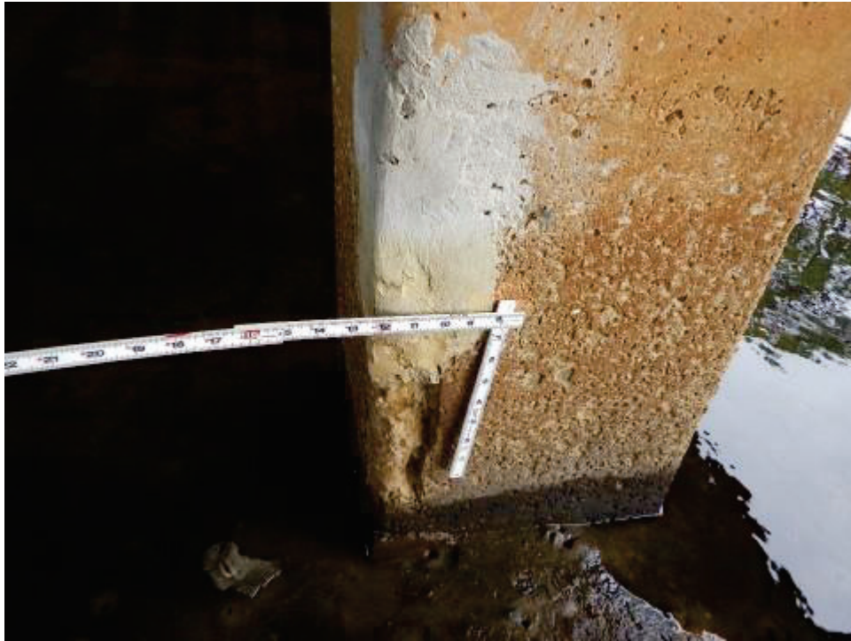
227 - Re Conc Pile
