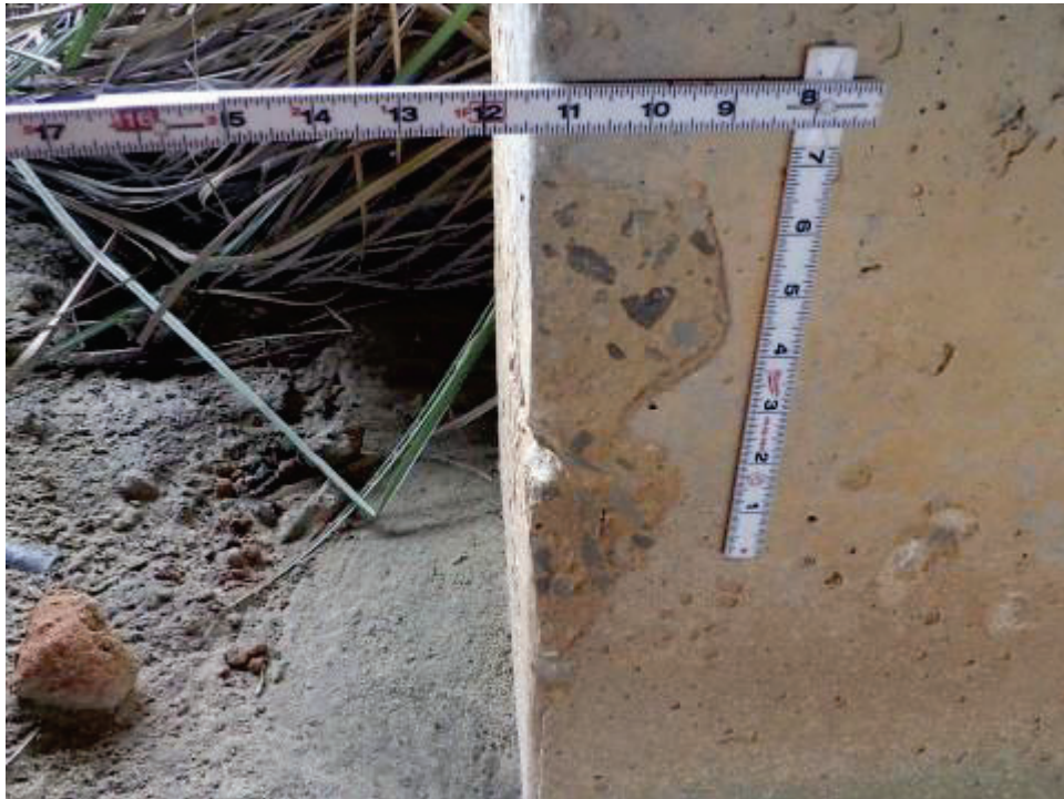
227 - Re Conc Pile
