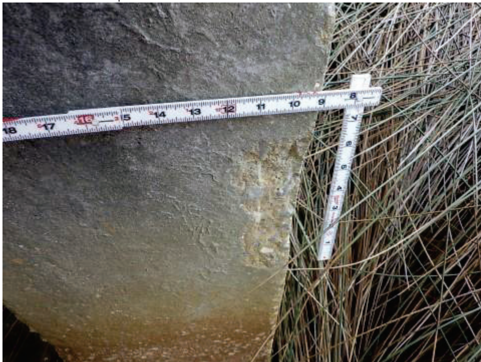
227 - Re Conc Pile
