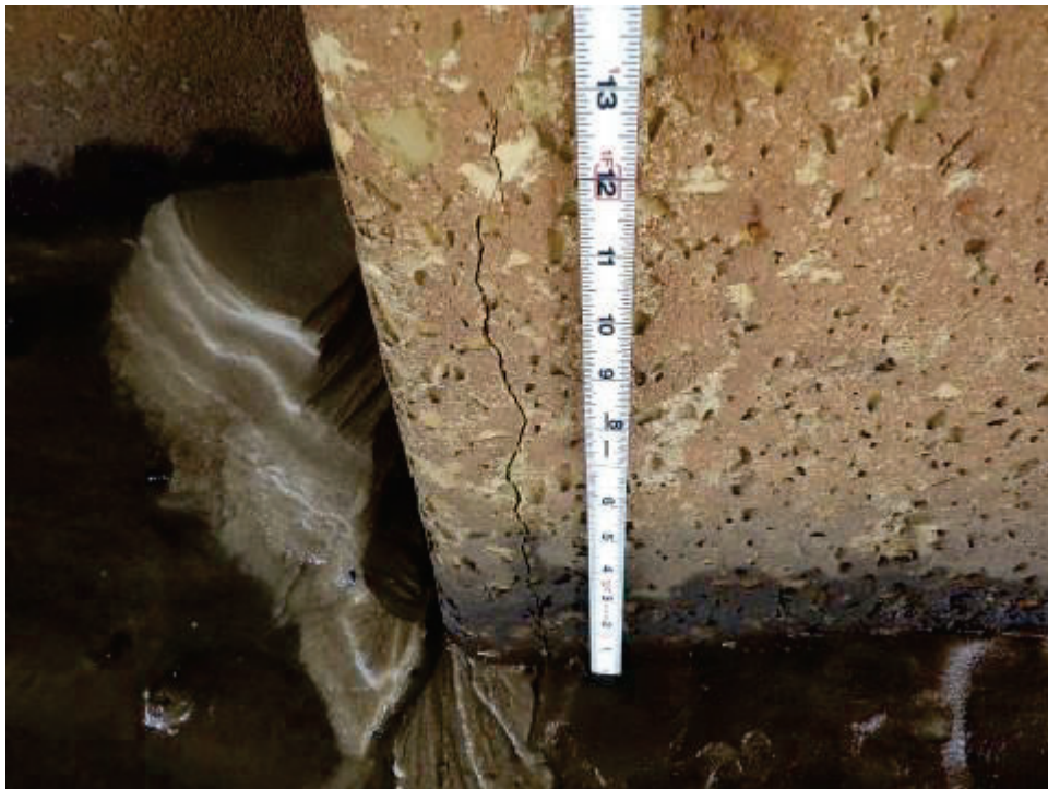
227 - Re Conc Pile
