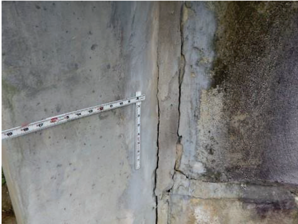
227 - Re Conc Pile
