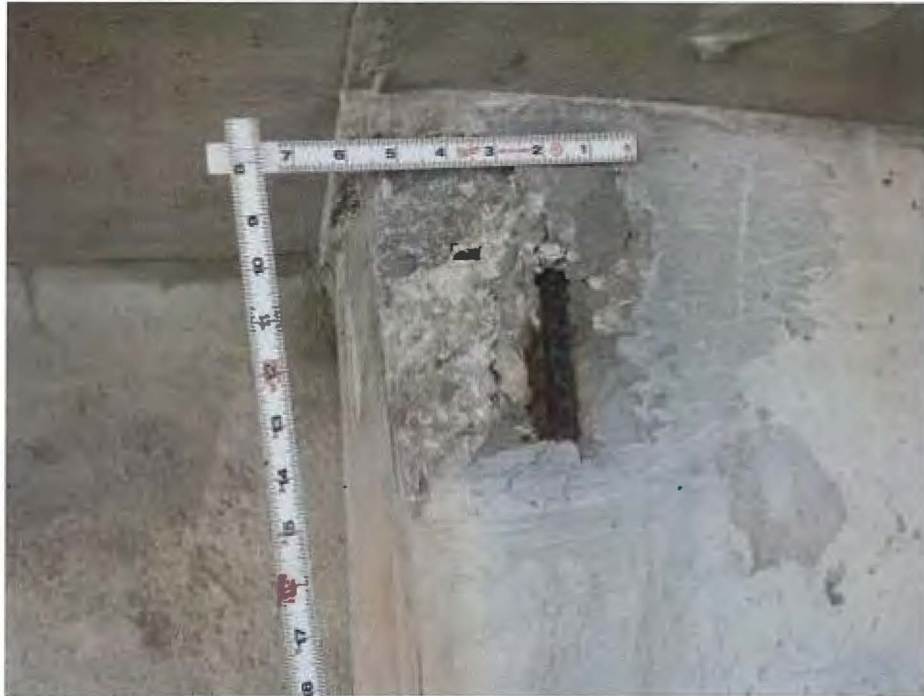
227 - Re Conc Pile
