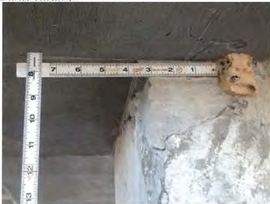
227 - Re Conc Pile
